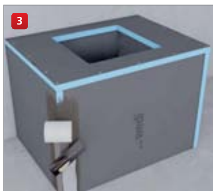
... Stoßverbindungen armieren ...
