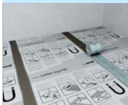
... ggf. Stöße abdichten.
